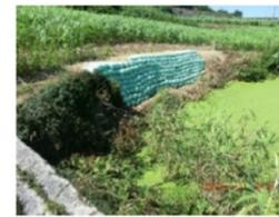
土のうによる崩落箇所の拡大防止
