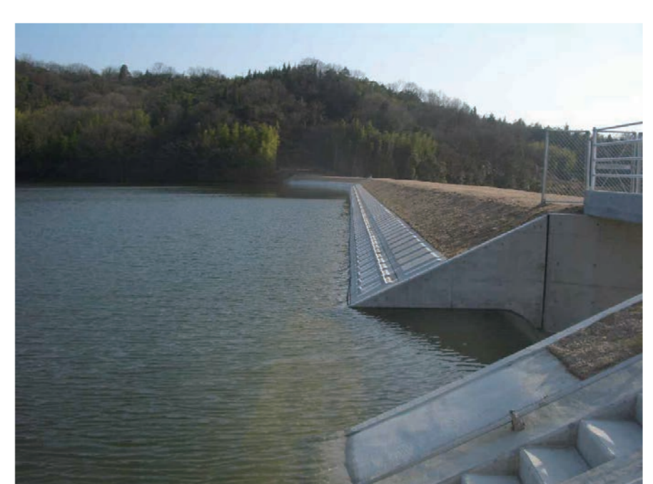
ため池(施工後)
