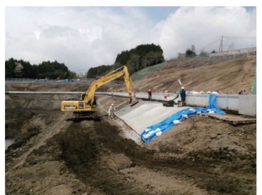
静岡県内 一般廃棄物最終処分場
