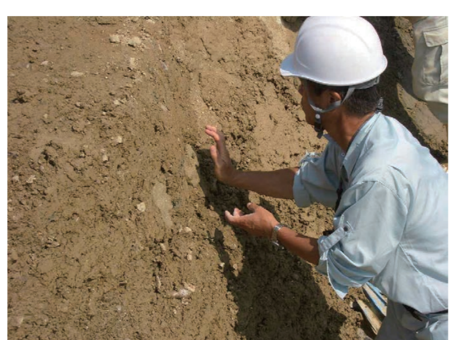
ため池(ベントナイト混合土による一部補修状況)
