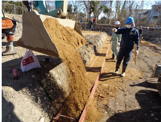
型枠内に高規格刃金土投入
