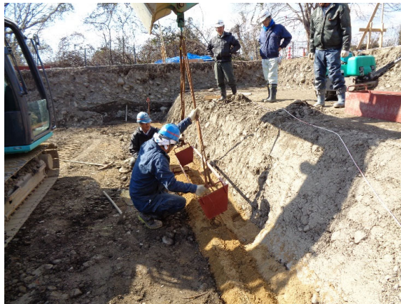
型枠引き抜き
