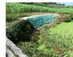
土のうによる崩落箇所の拡大防止
